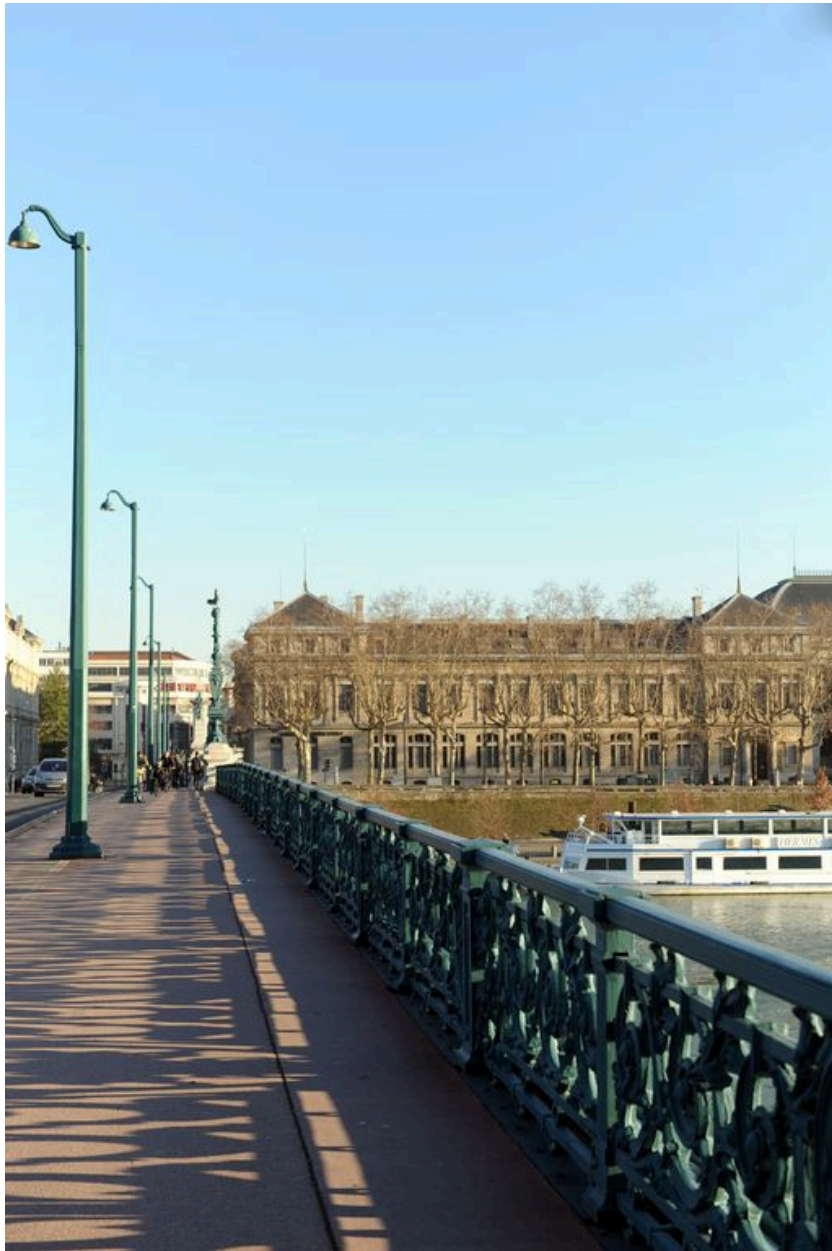
Vue partielle, de dessus, trottoir et balustrade, face amont (depuis la chaussée)
