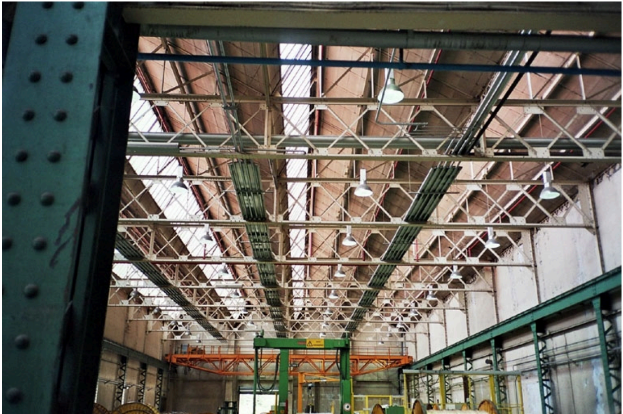
Charpente détail structure
