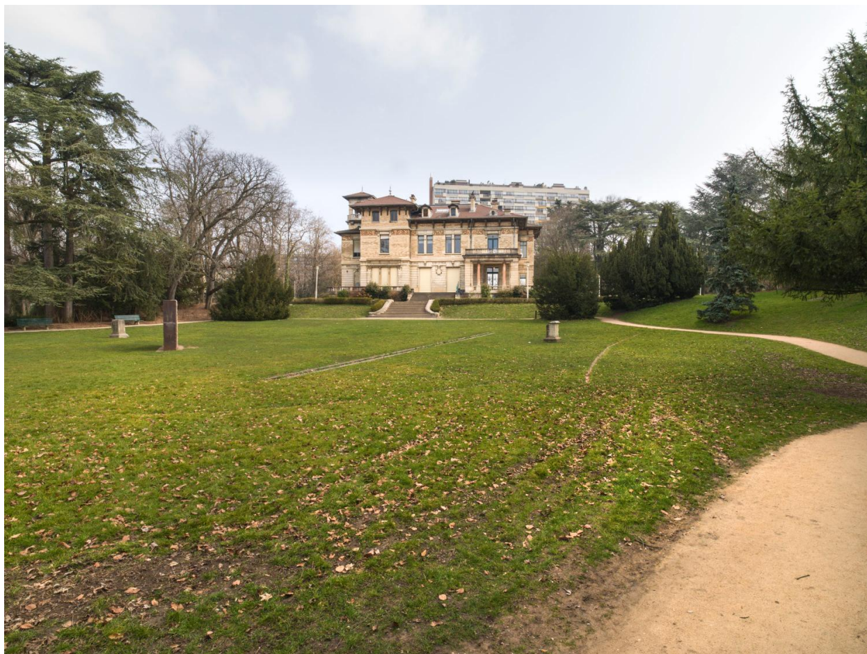
Vue ouest du parc
