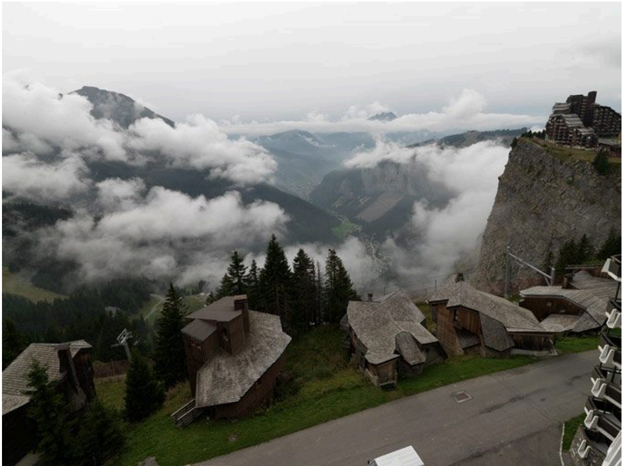
Chalets nord-ouest du quartier des Dromonts. Ensemble des toitures
