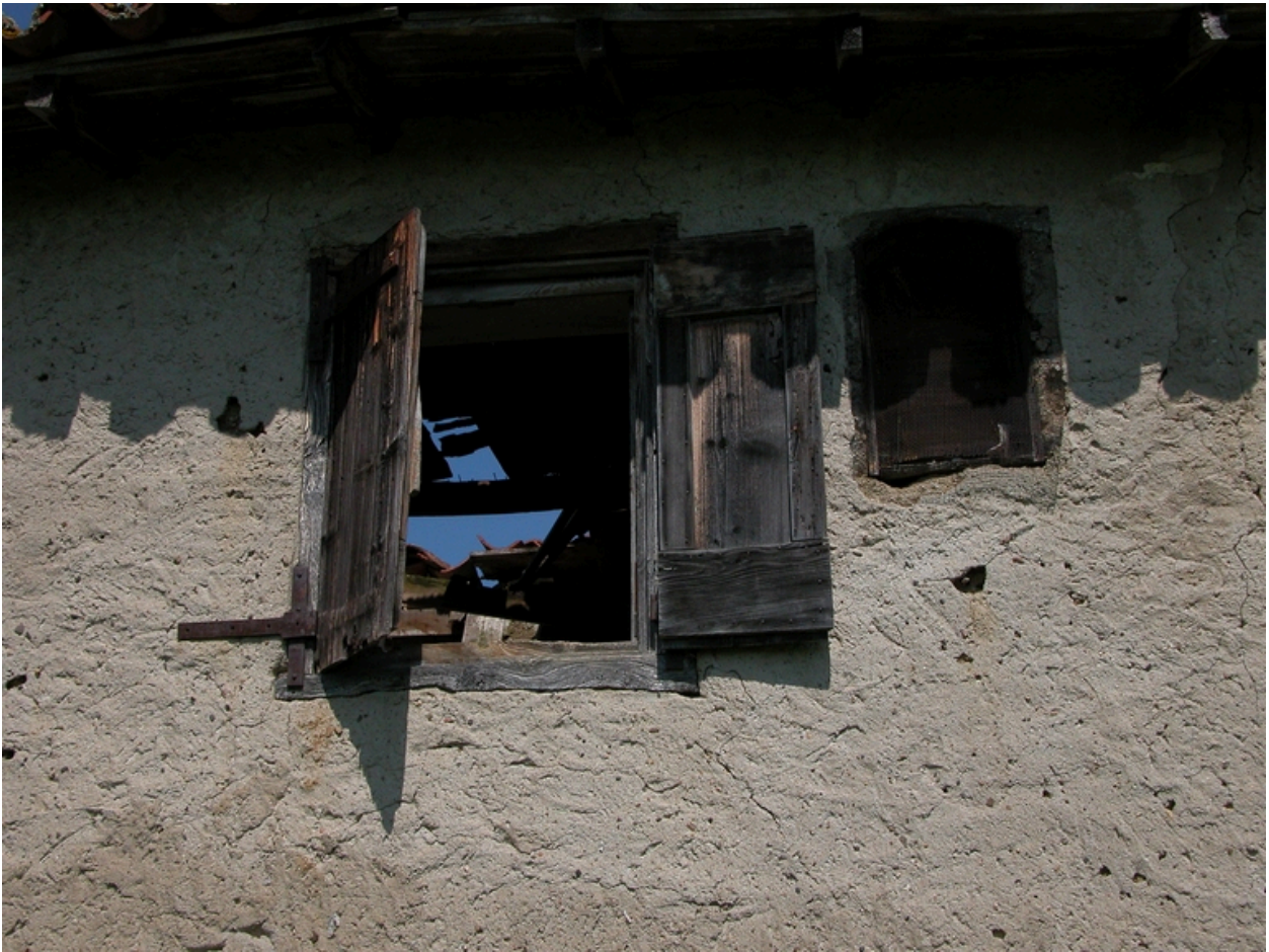
Détail de la fenêtre du 1er étage et de la niche à statuette.
