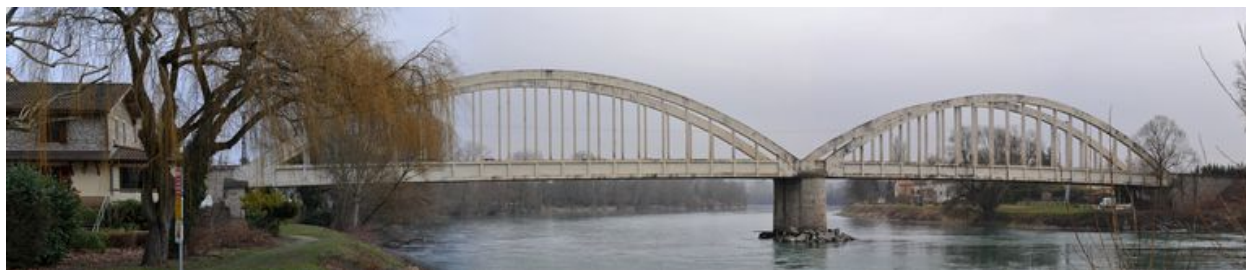
Vue panoramique, face aval (depuis la rive droite)
