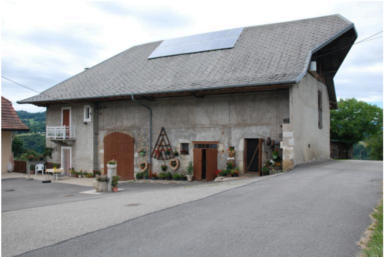
Vue d'ensemble du bâtiment principal.
