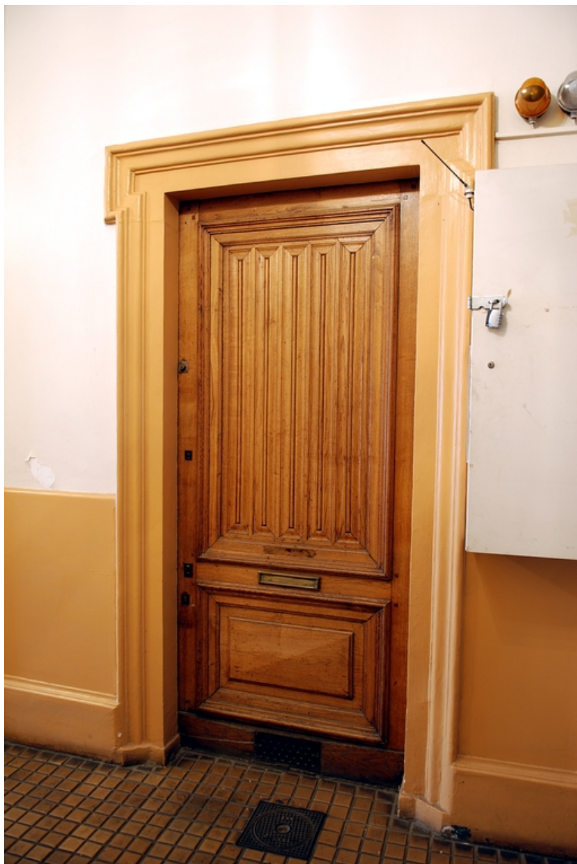
Le passage cocher : porte en menuiserie
