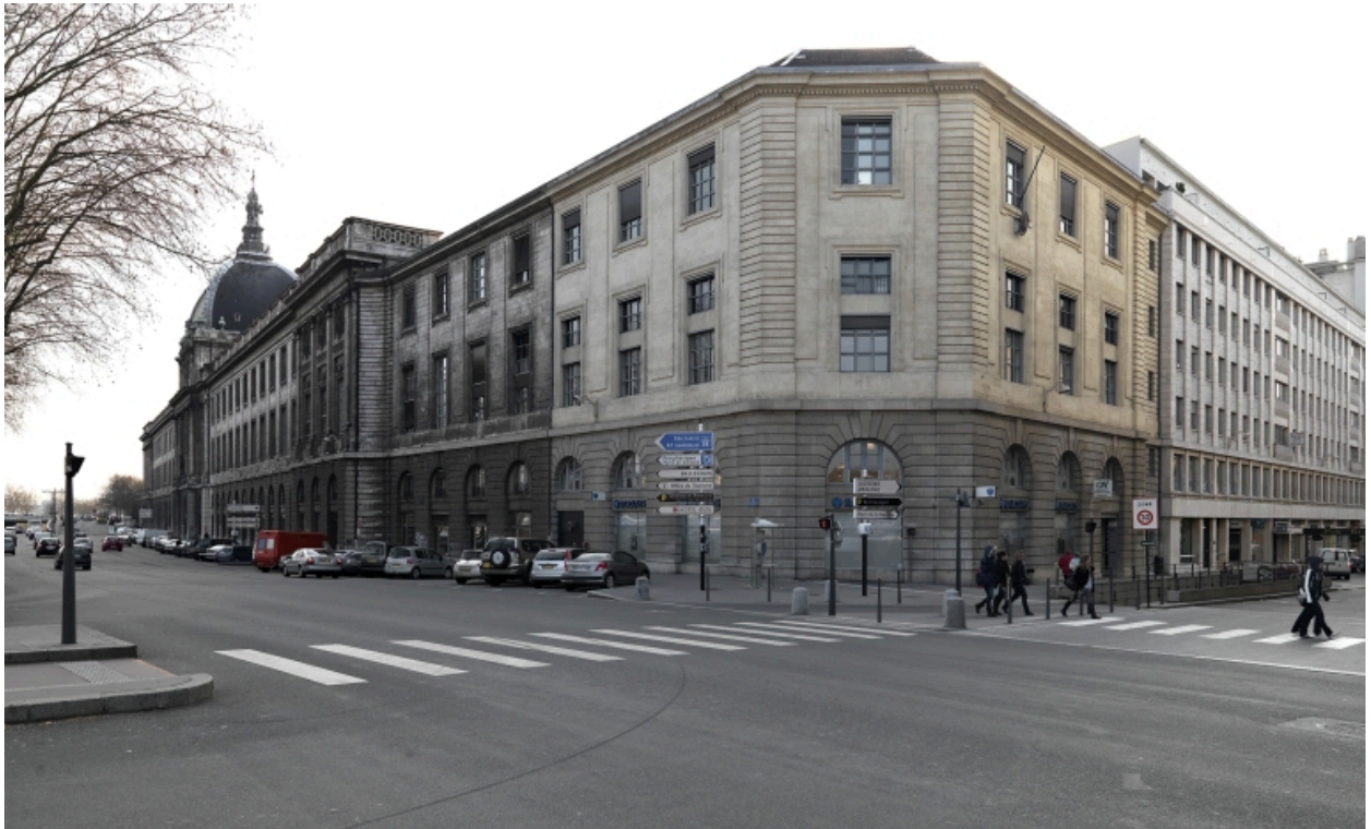
Les façades est et nord (quai Jules-Courmont, rue Childebert)
