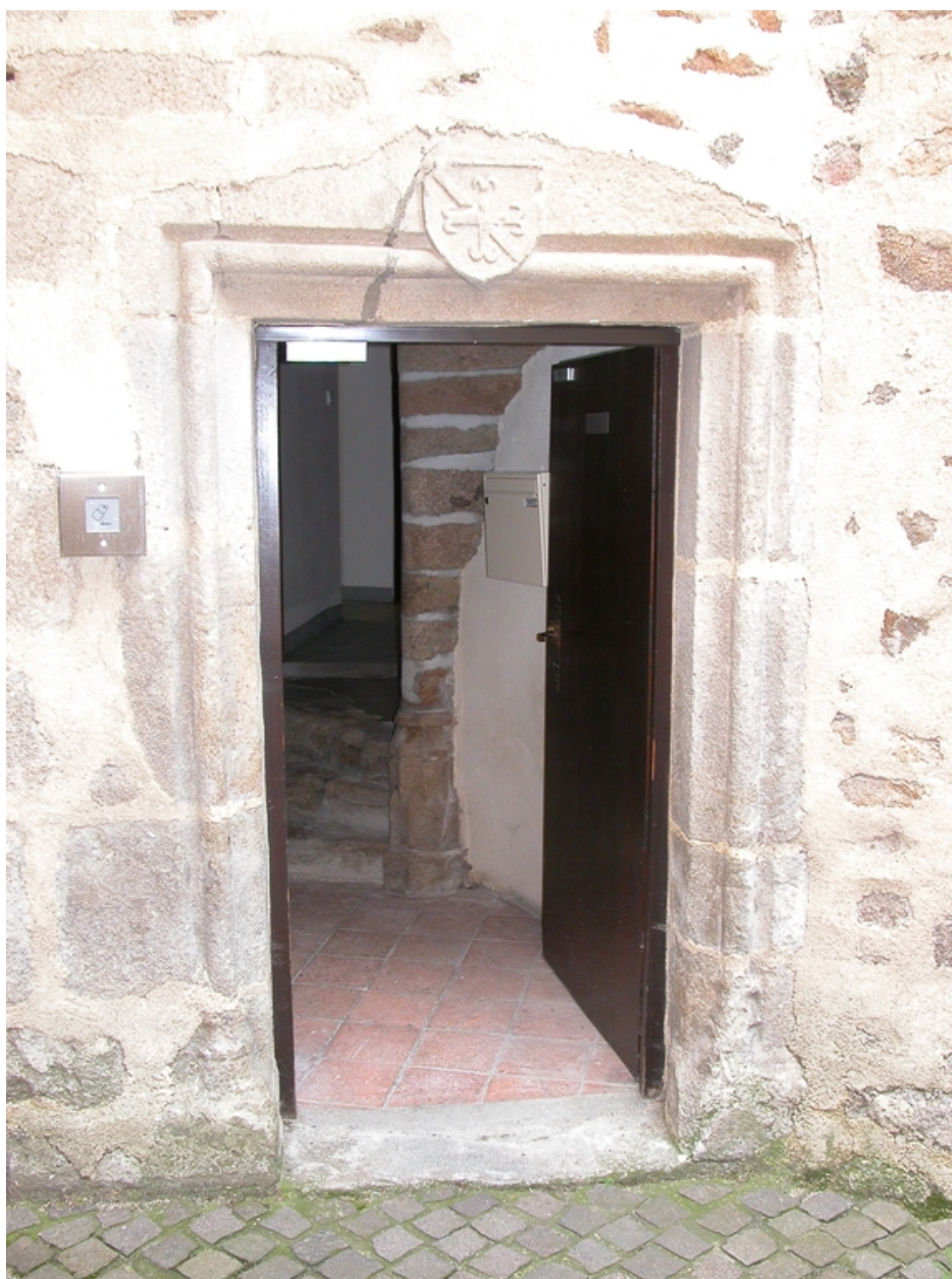
Vue intérieure de la cour : porte de la tour d'escalier, départ de l'escalier en vis en arrière-plan.
