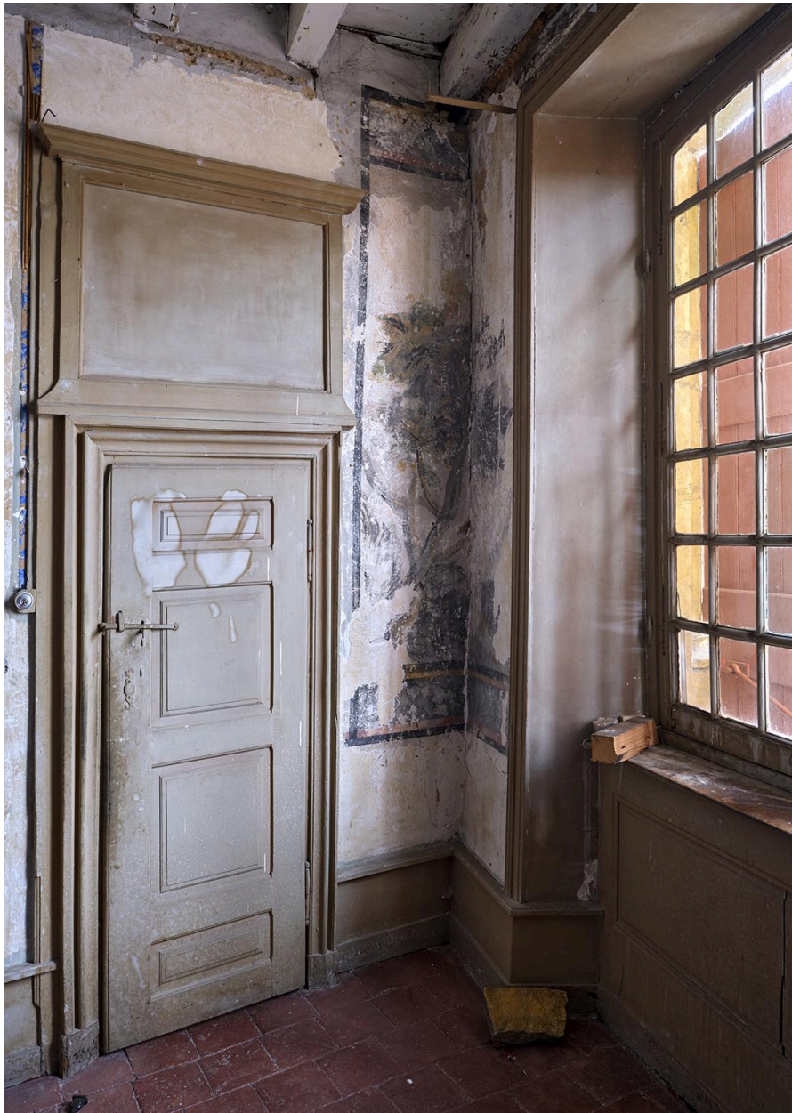
Etage carré, chambre 5, vue d'ensemble en direction du nord-est. Détail des peintures situées dans l'angle de la chambre.
