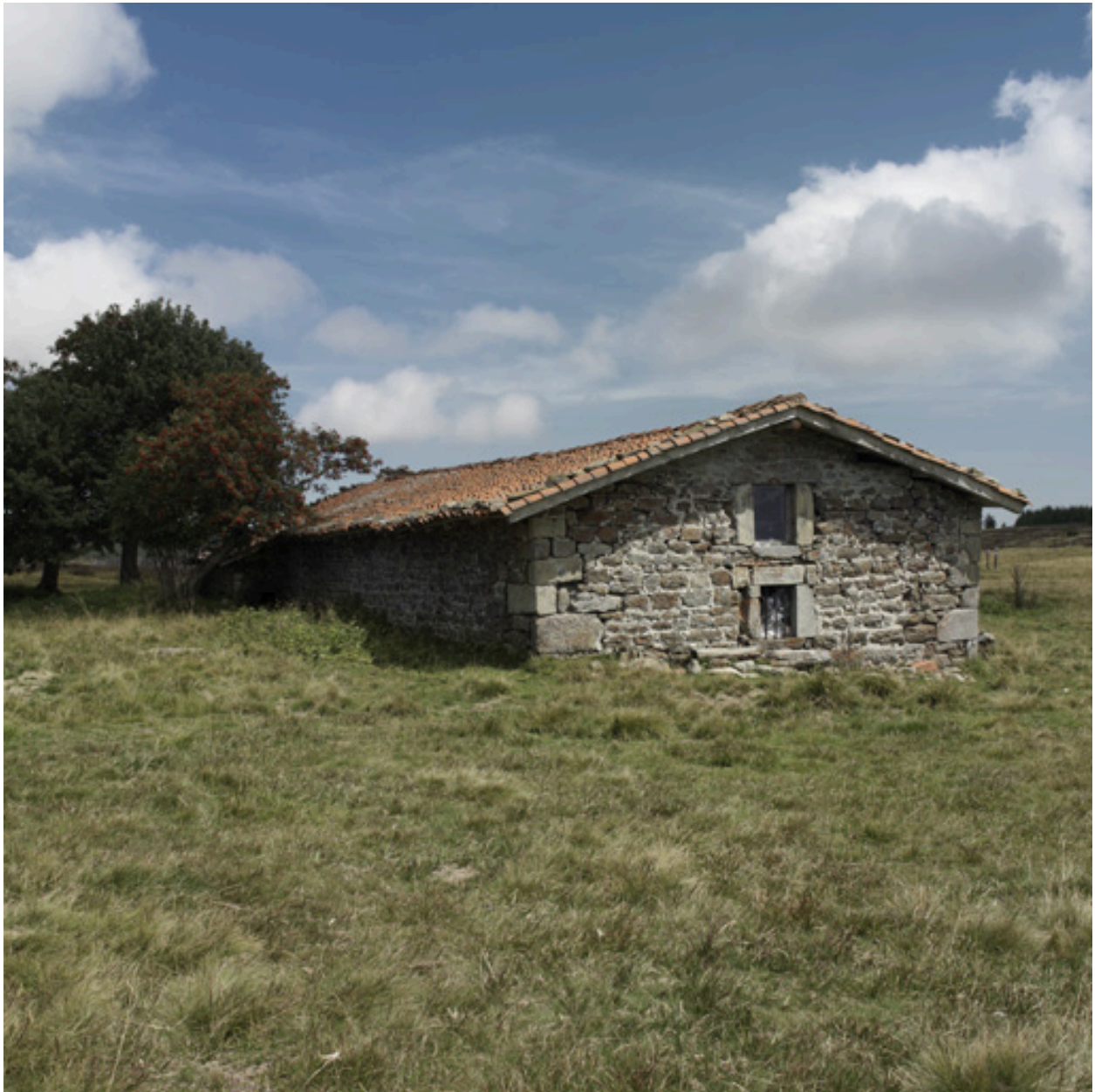
Vue du pignon sud.
