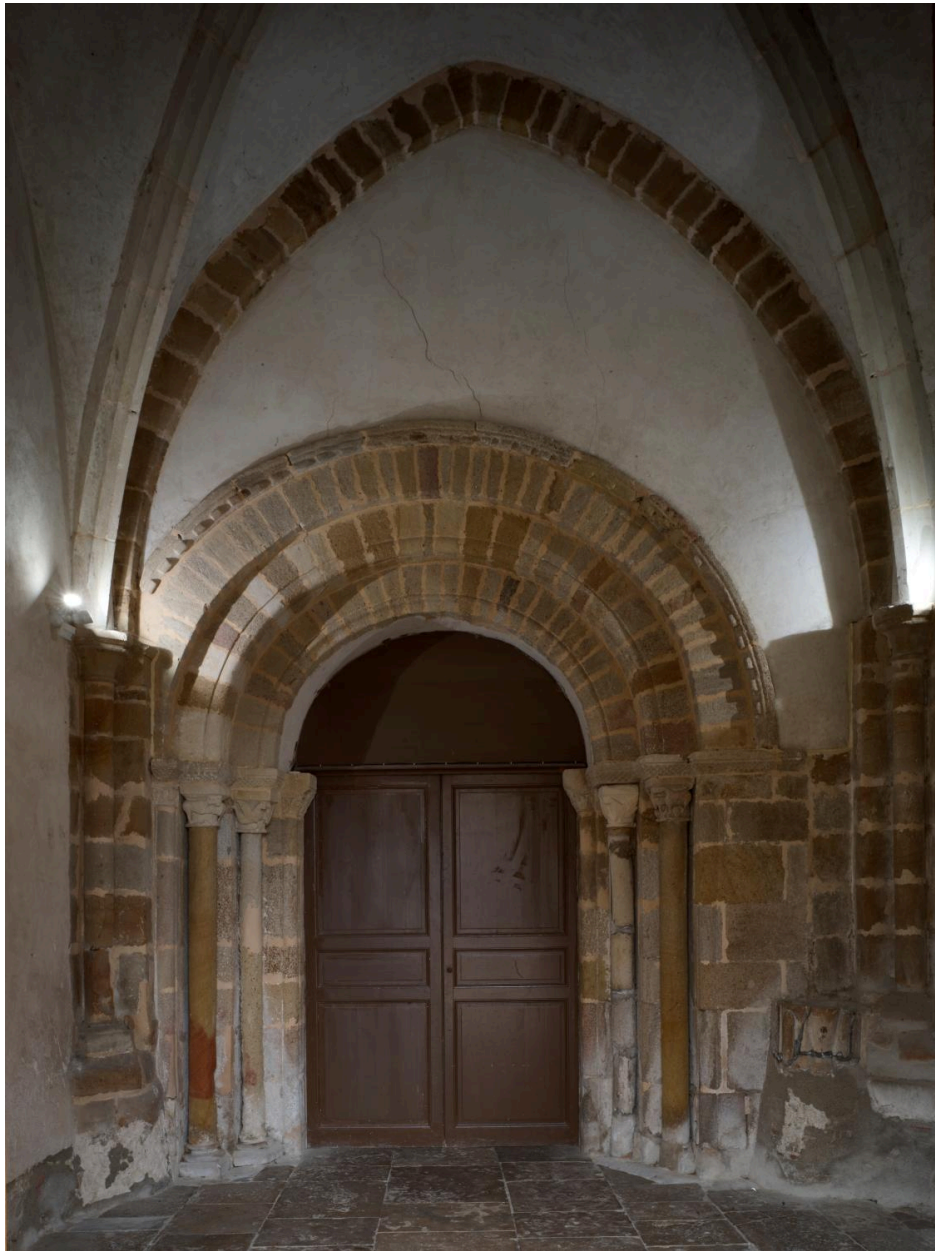
Vue de l'ancien portail occidental situé dans l'avant-nef.
