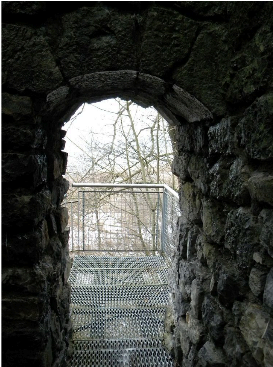
Porte d'entrée depuis l'intérieur.
