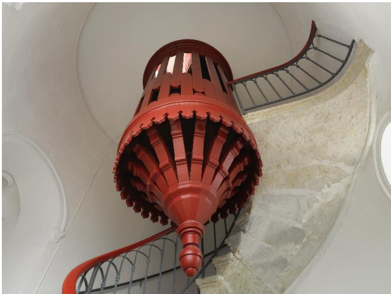
Vue intérieure : le sommet de l'escalier et le lanternon en charpente
