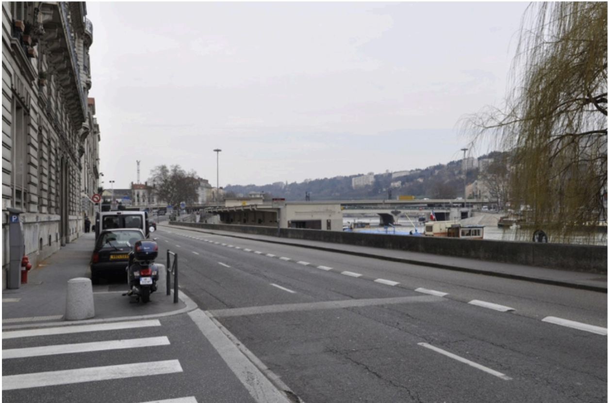
Vue du site du quai Maréchal Joffre
