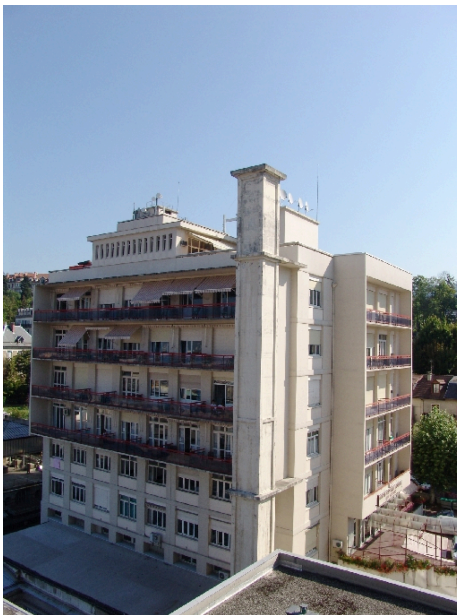
Vue prise du sud-ouest
