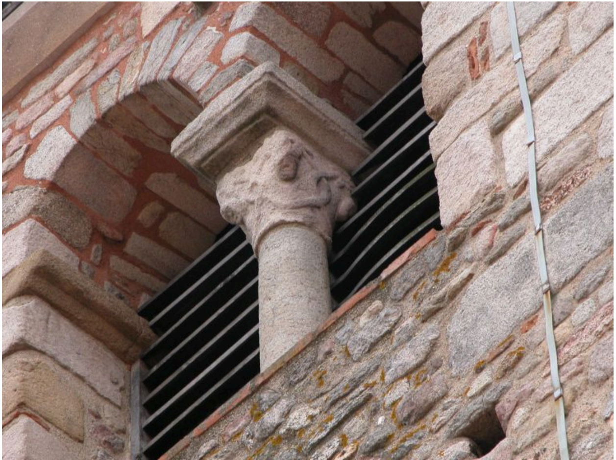
Détail de baies jumelées du clocher, face nord.
