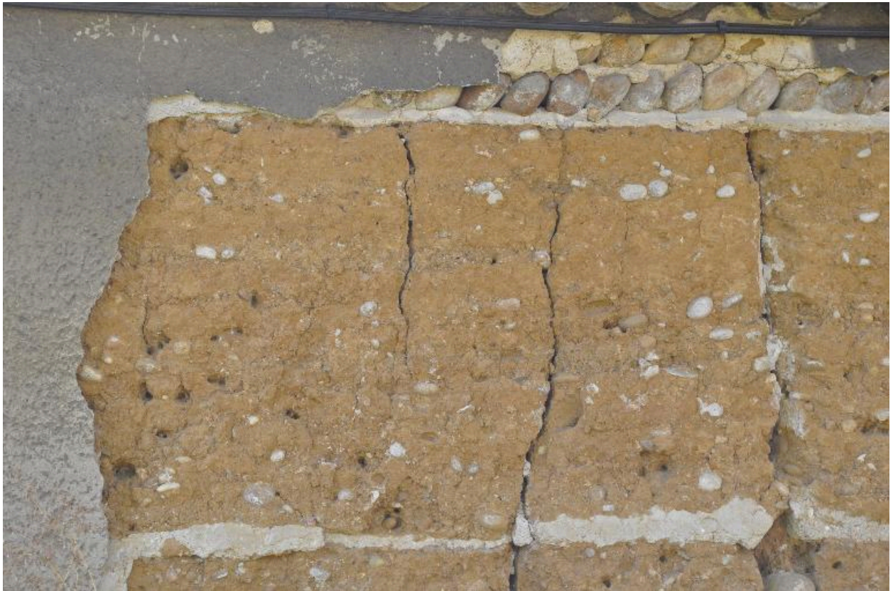
Mur de clôture sud, détail du pisé et rang de galets
