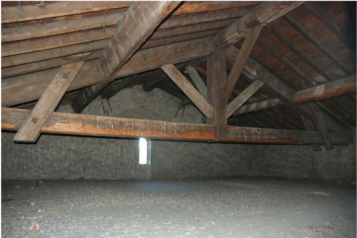
Combles : vue de la charpente
