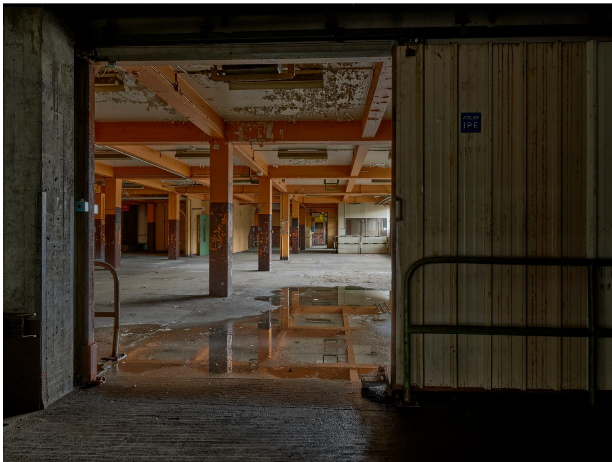
Détail intérieur de l'atelier O26, désaffecté.
