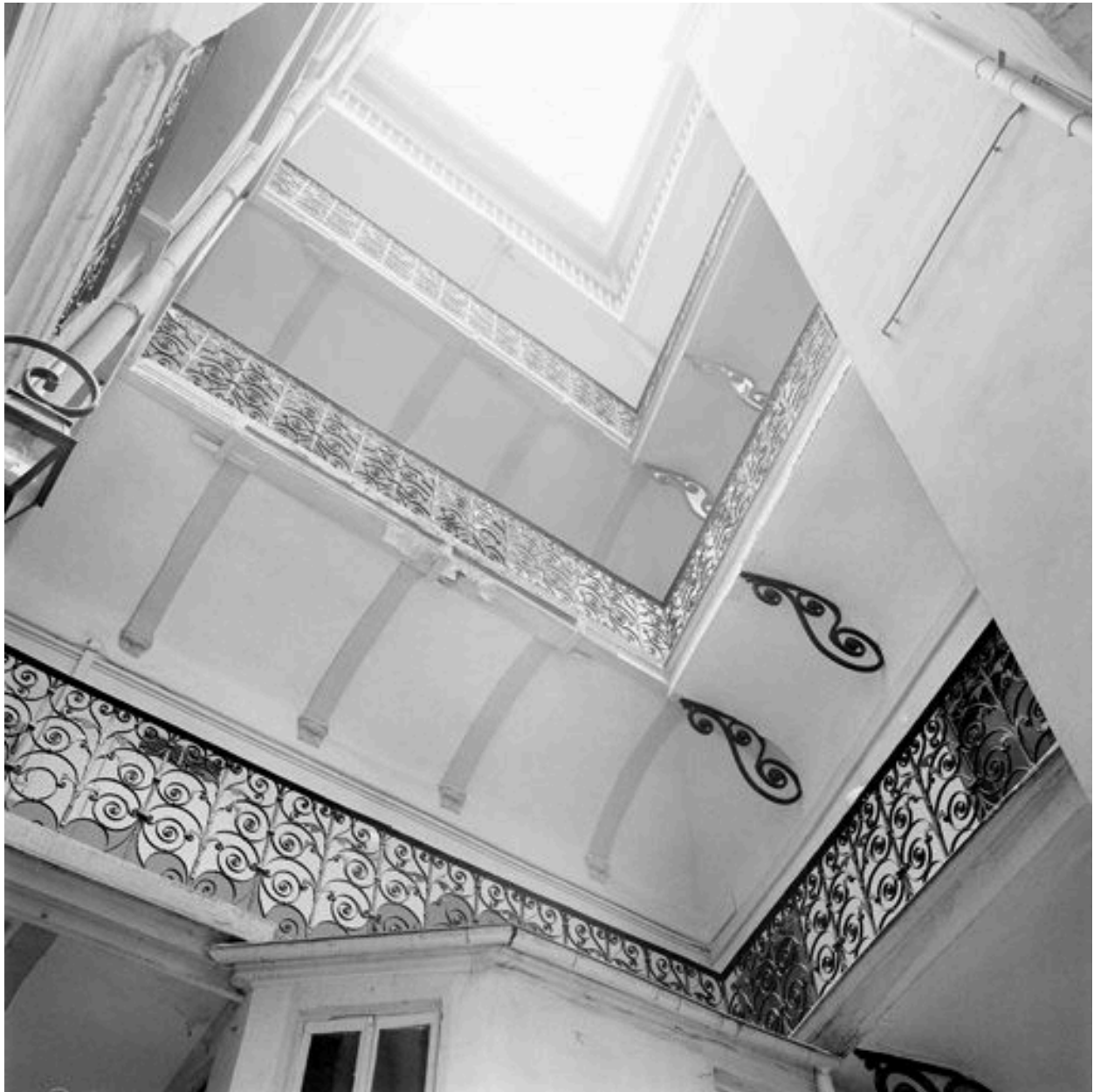
Cour, vue générale des coursières de liaison (à gauche) et de celles desservant le corps arrière (à droite)
