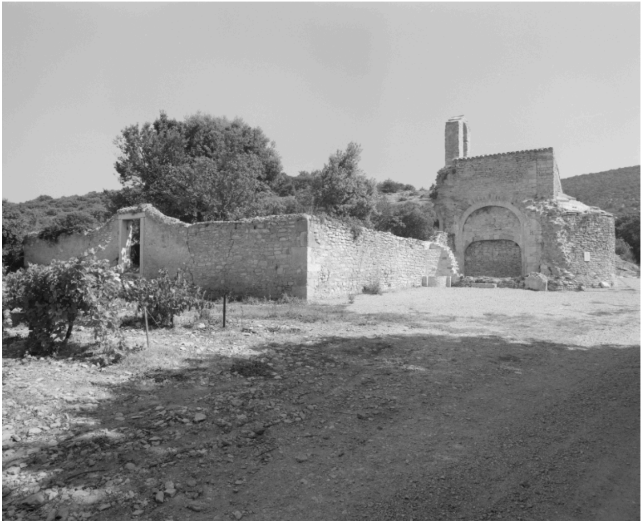
Vue d'ensemble du prieuré, depuis le sud.
