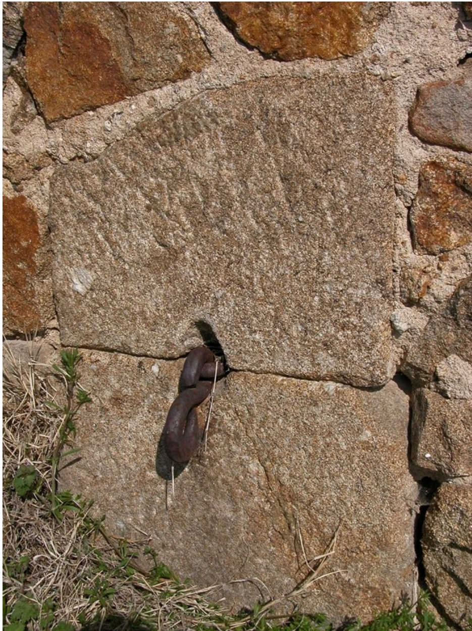
Détail d'un anneau scellé dans une pierre d'angle.
