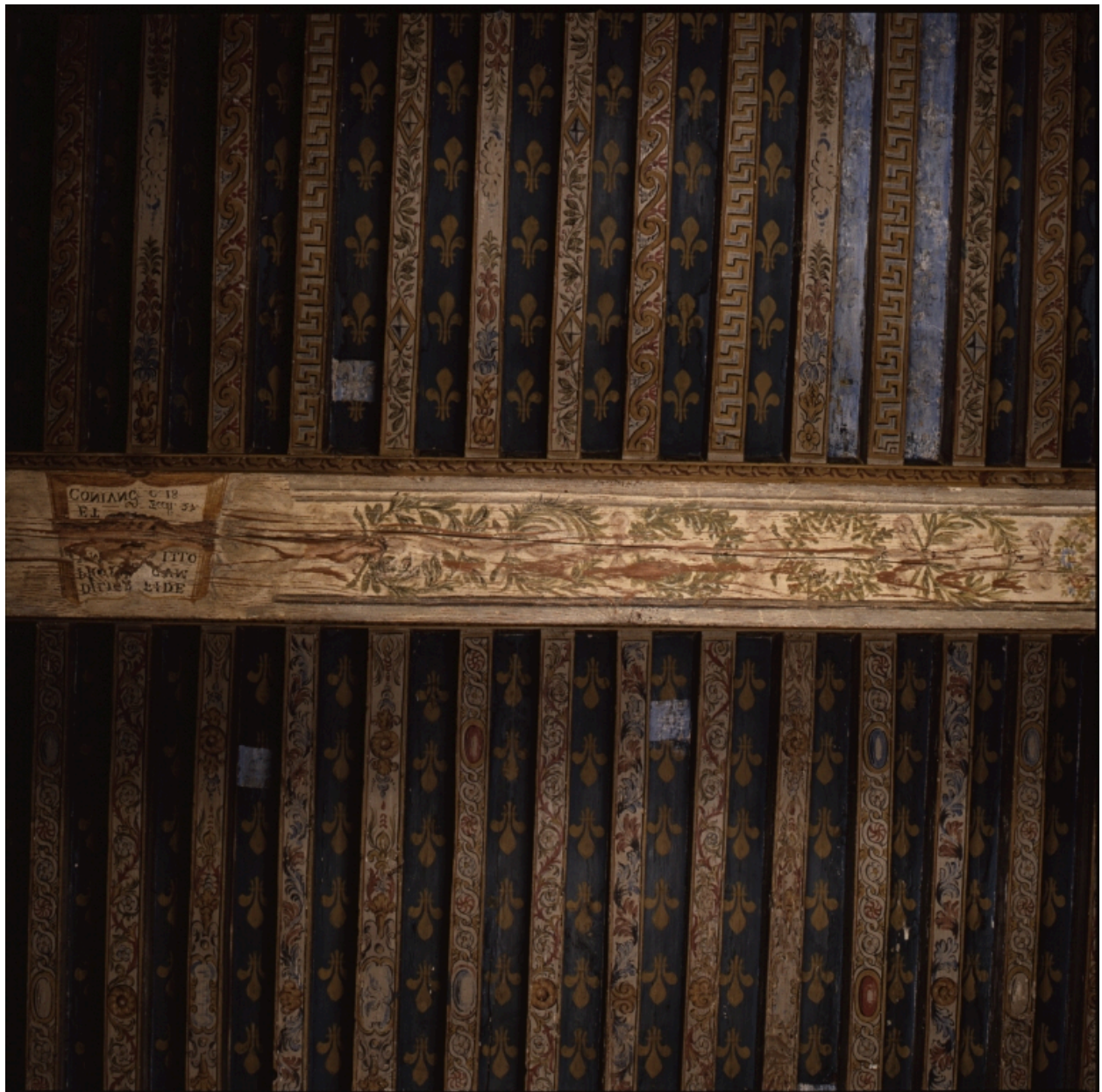
Poutre 5, face inférieure, centre et côté droit.
