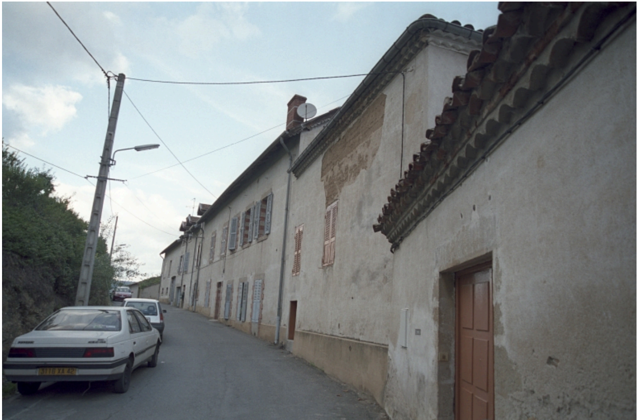
Vue d'ensemble de la façade sur rue.
