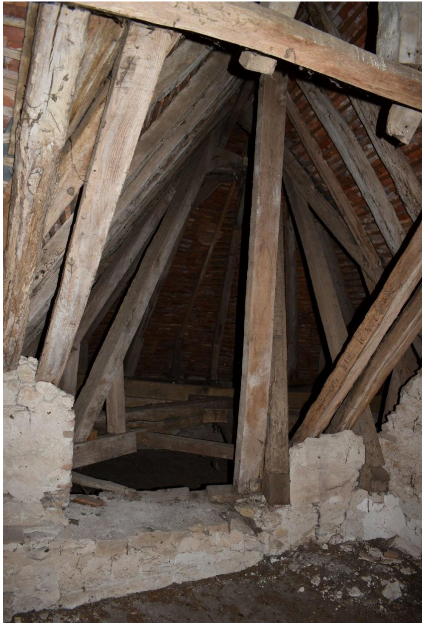
Vue de la charpente de la tour de l'ancien logis.
