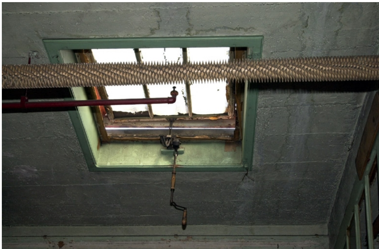
Lucarne, vue de l'intérieur
