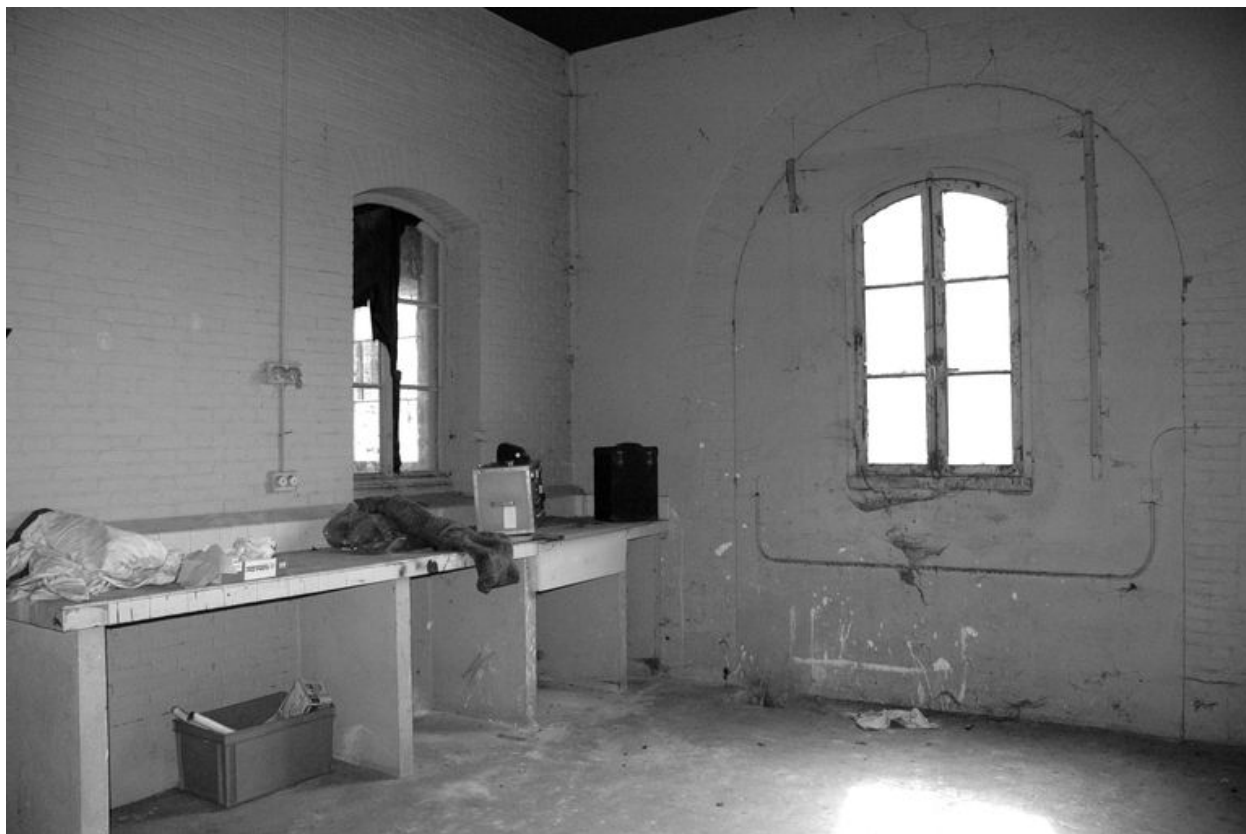
Gymnase, vue intérieure du rez-de-chaussée, état juin 2008
