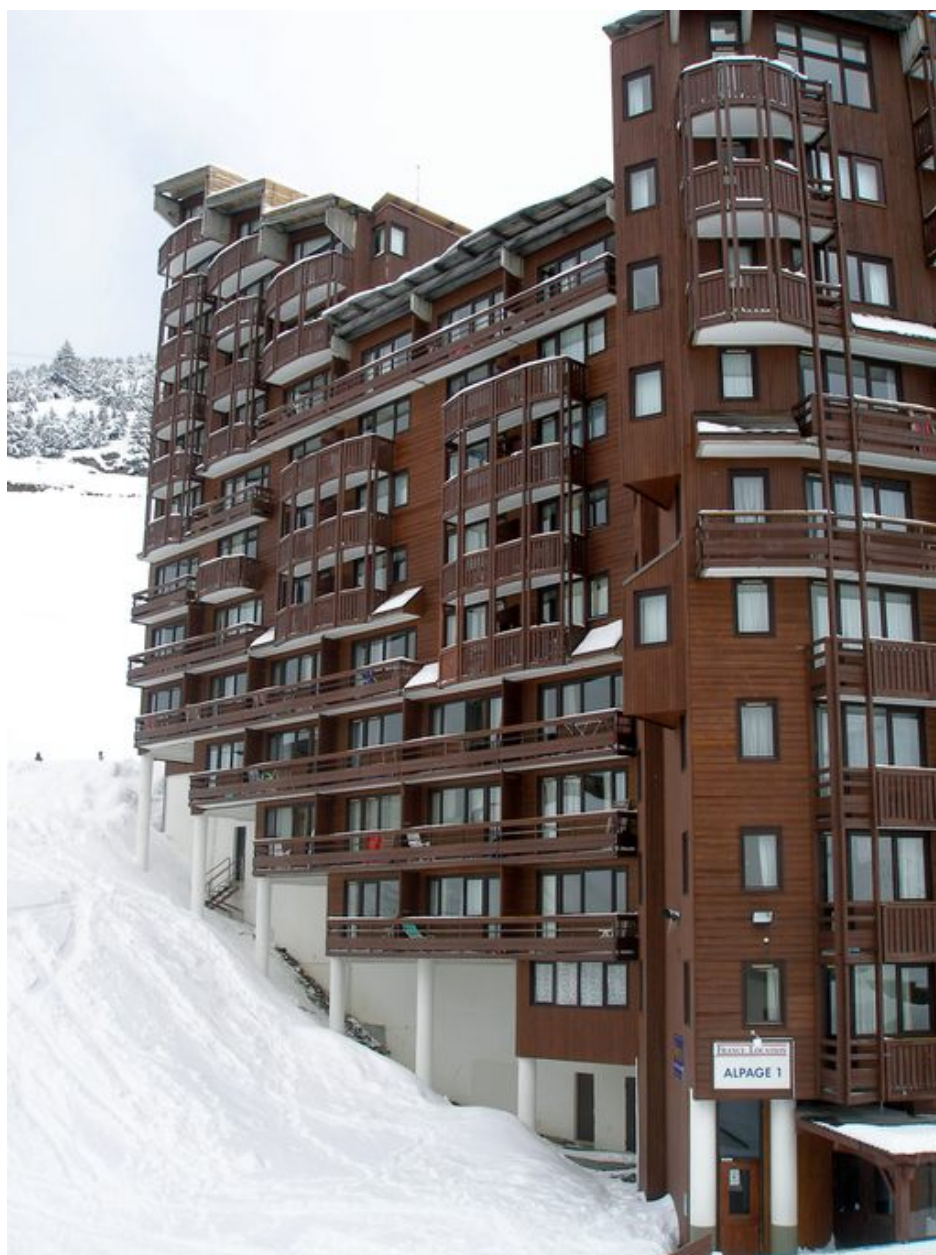
Façade ouest, vue depuis le sud
