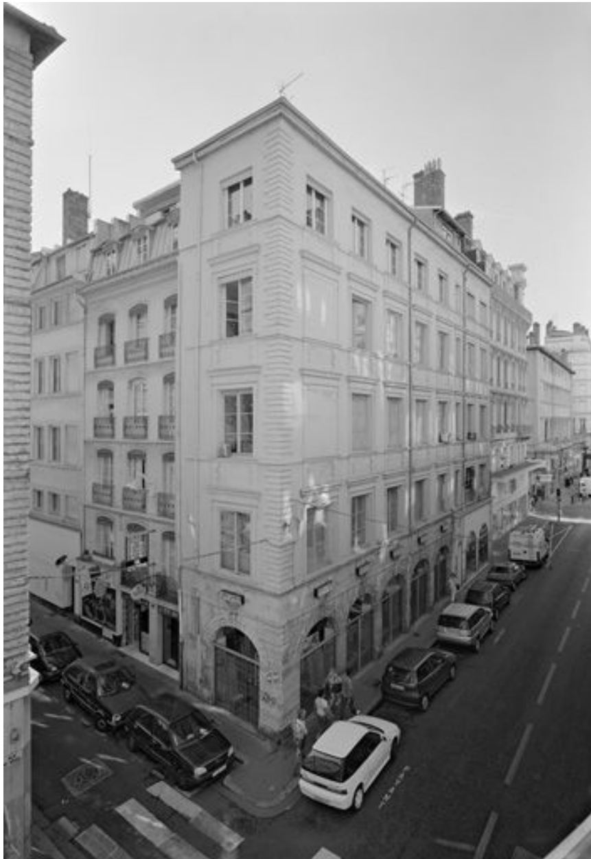
Façade, vue générale (à gauche)
