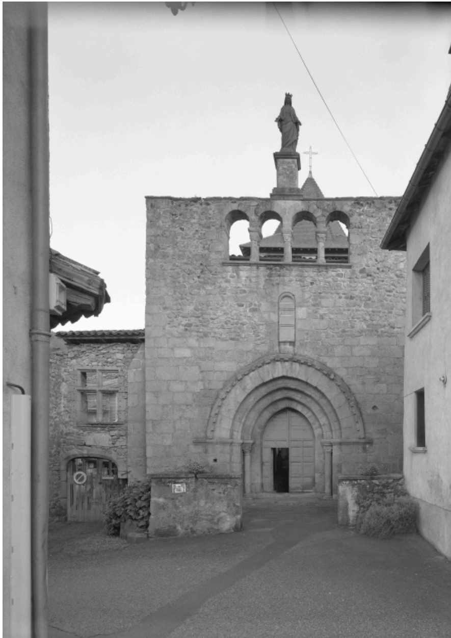
Vue d'ensemble de la façade occidentale.
