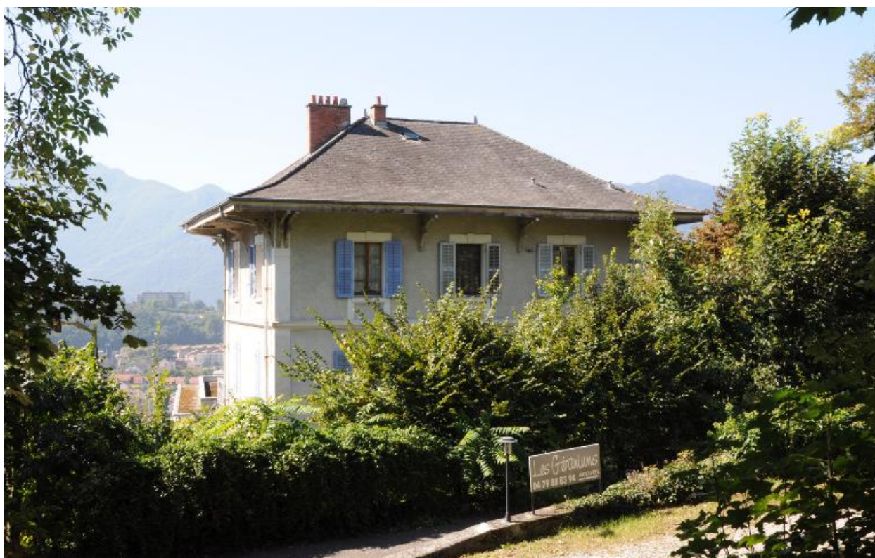
Vue de trois-quart depuis l'est
