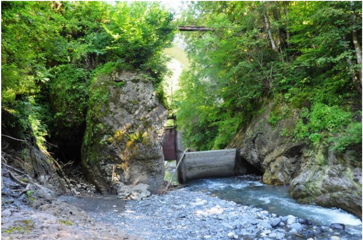
Vue amont de la prise d'eau. A gauche, départ de la dérivation souterraine.
