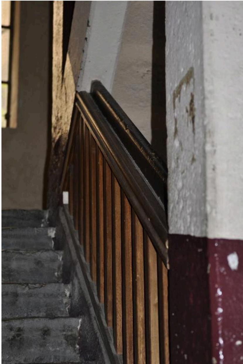
Remplissage dur mur noyau avec bareaux droits en bois dans l'escalier du n°7 rue Dumenge
