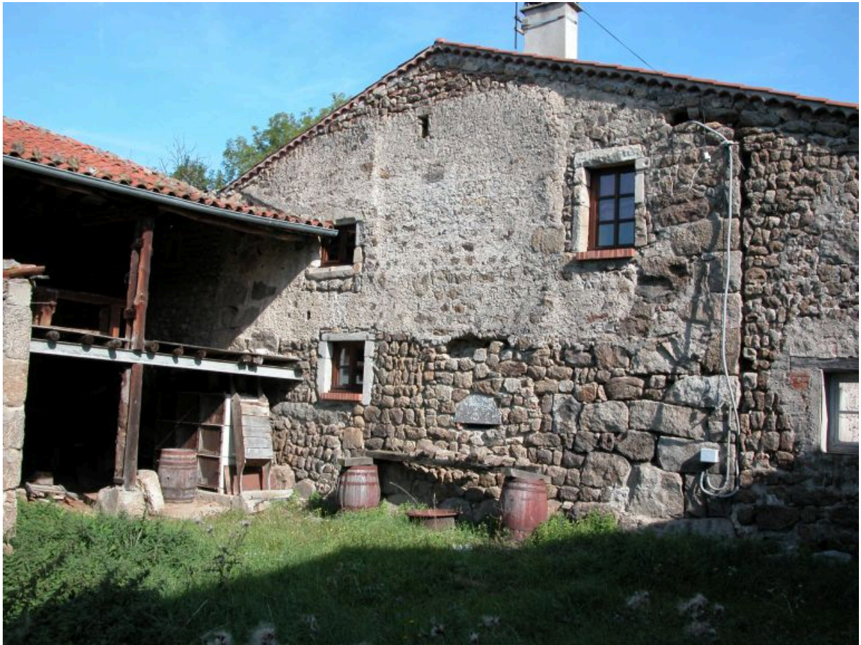
Vue d'ensemble de la façade latérale gauche du logis.
