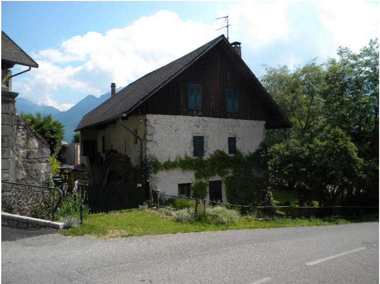
Vue du pignon sud d'une ancienne maison (2008 B2 389, 390)
