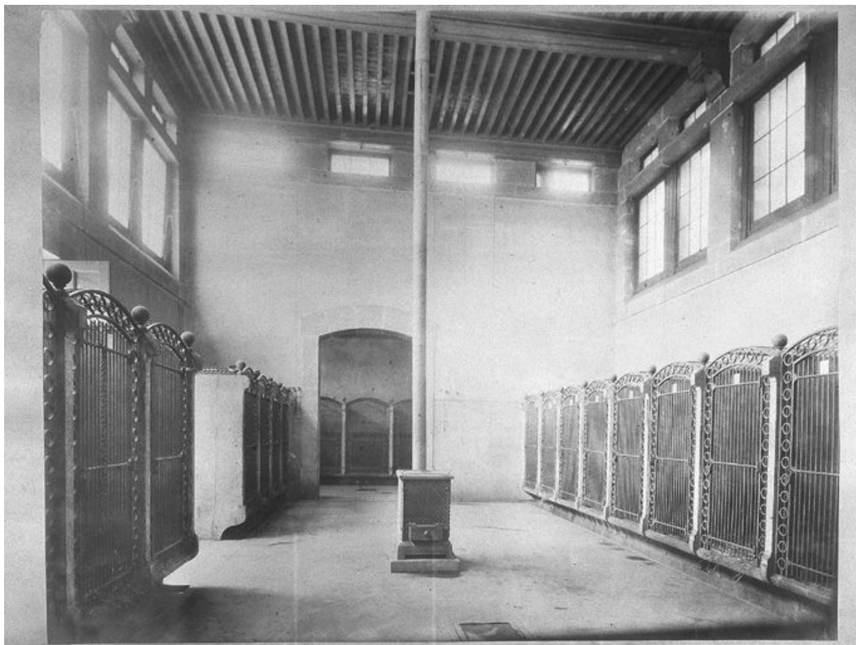
Ancien chenil, vue intérieure
