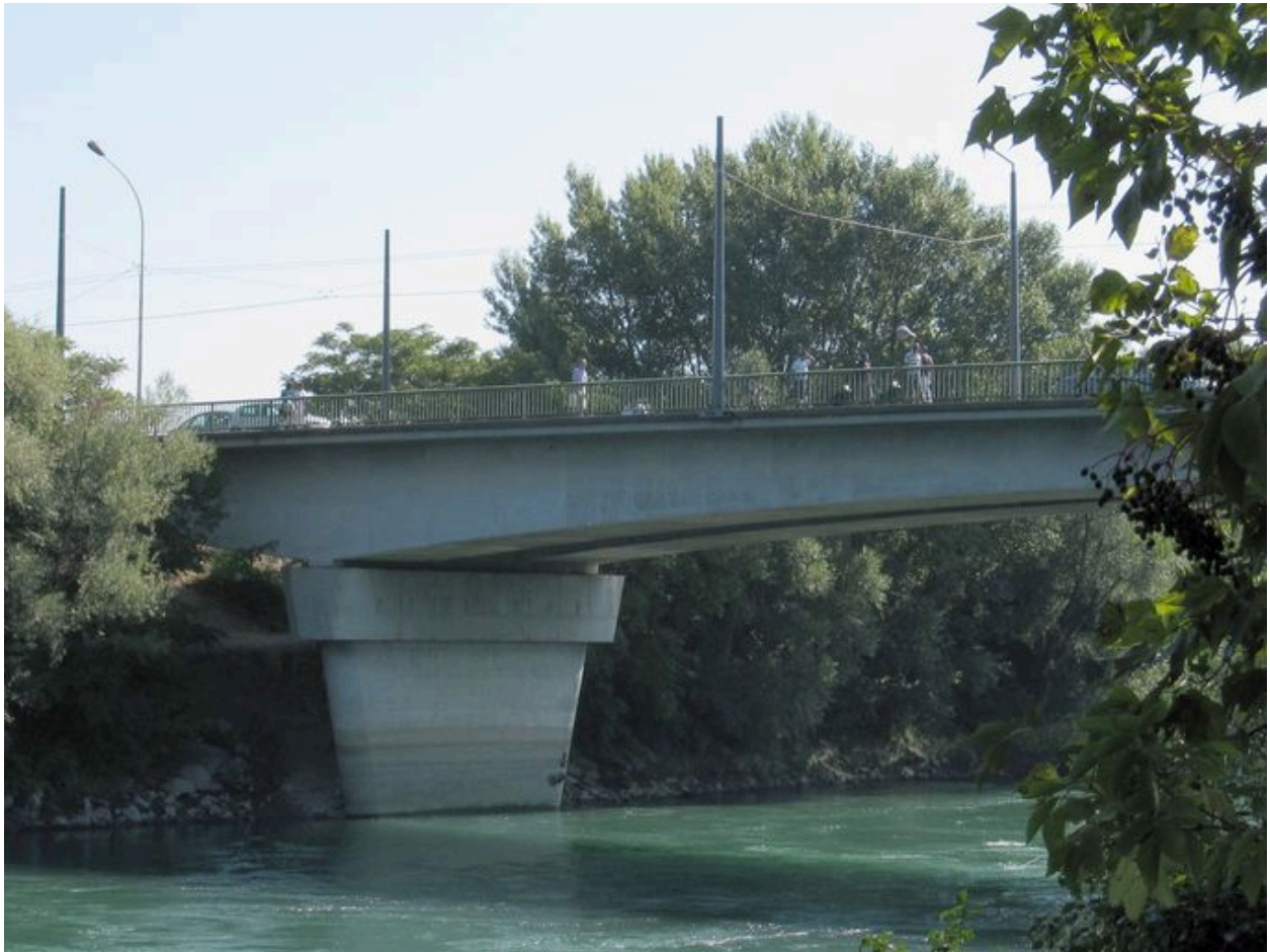
Vue partielle, face aval (depuis la rive gauche)
