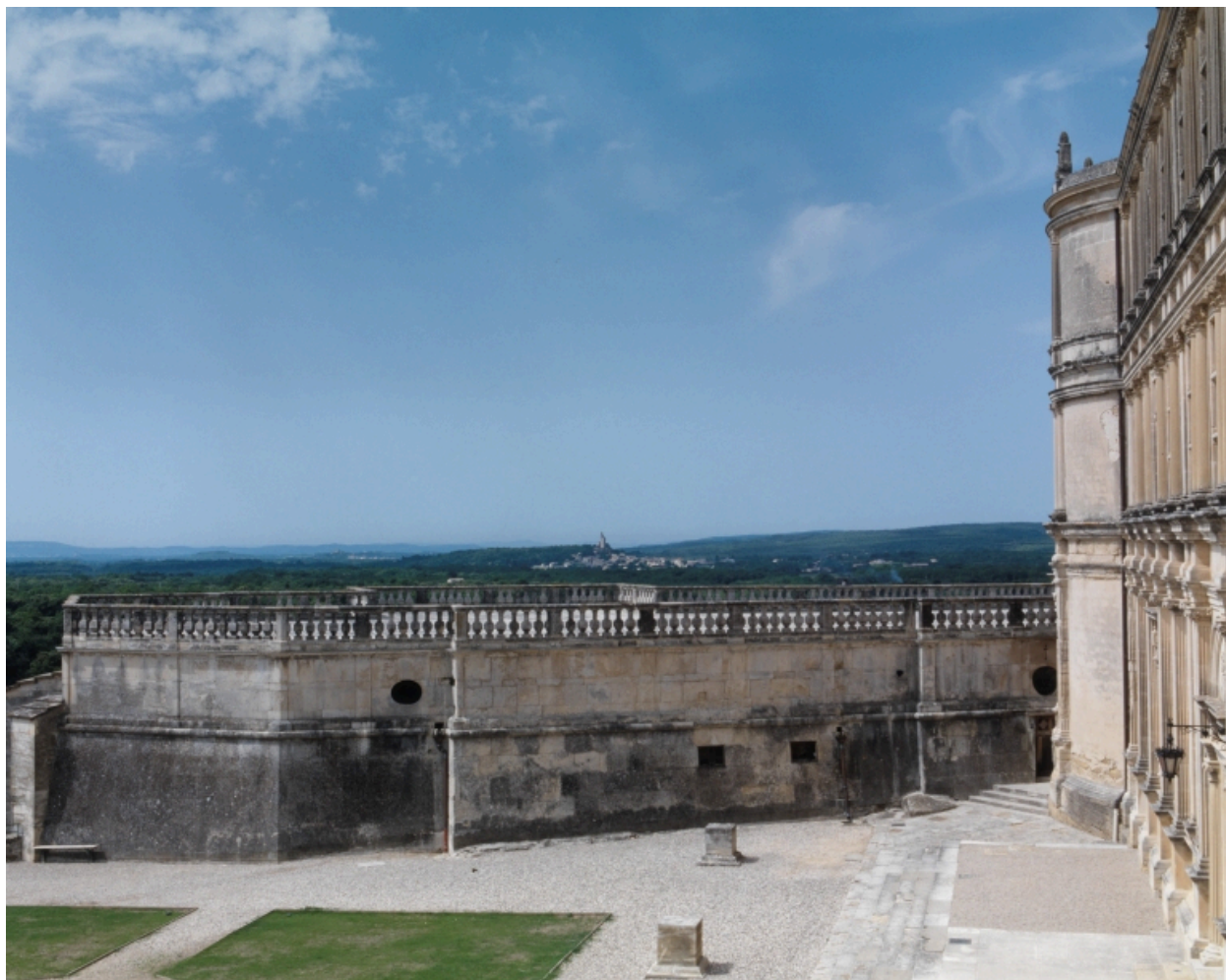
Bâtiment d'entrée. Détail d'une bouche à feu.
