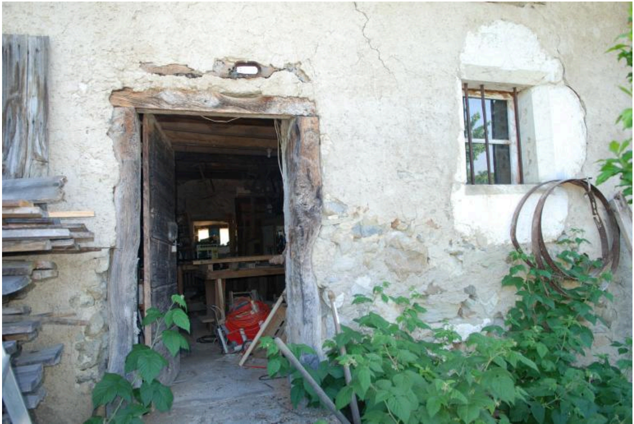
Grange-étable, ouvertures de l'atelier.
