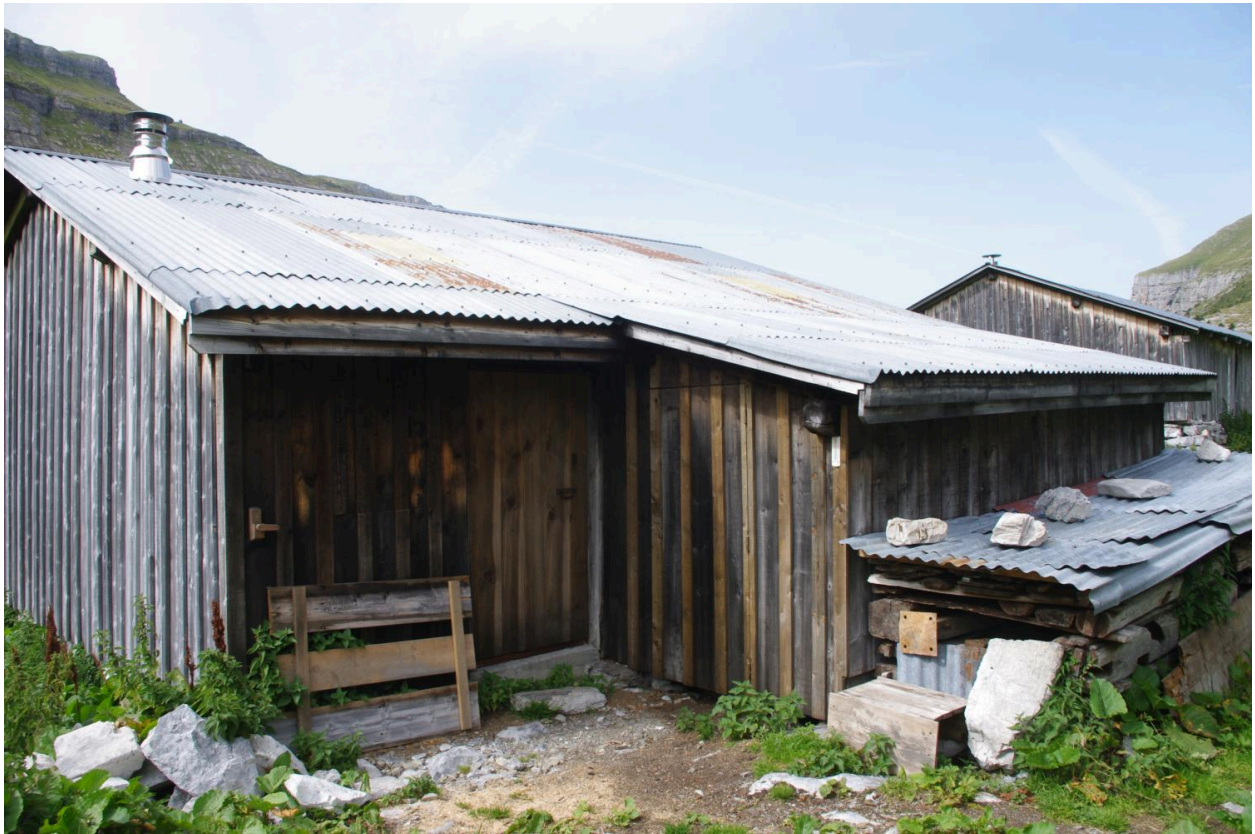
Vue de l'extension en appentis adossée à la façade postérieure est
