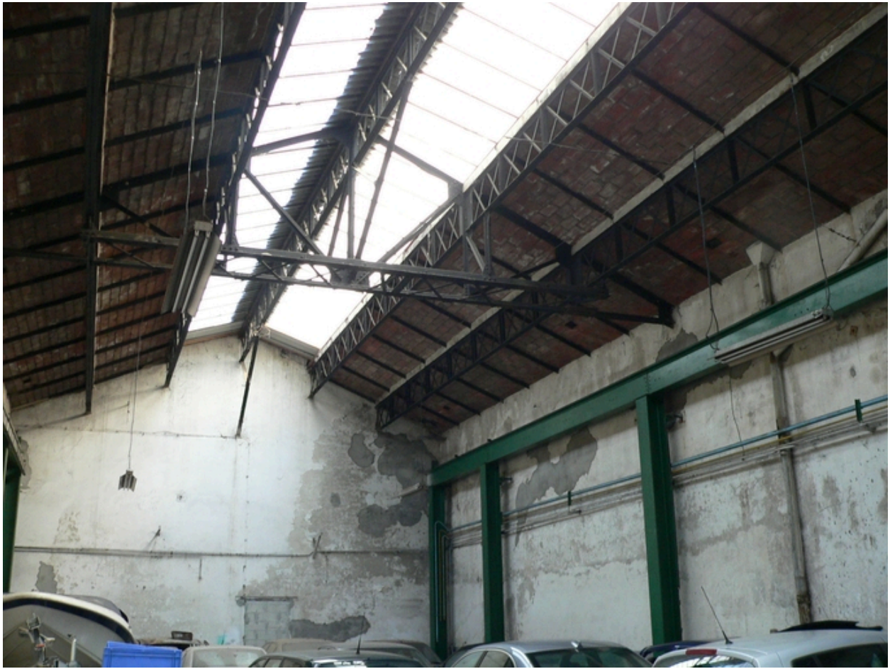
Toiture de l'atelier
