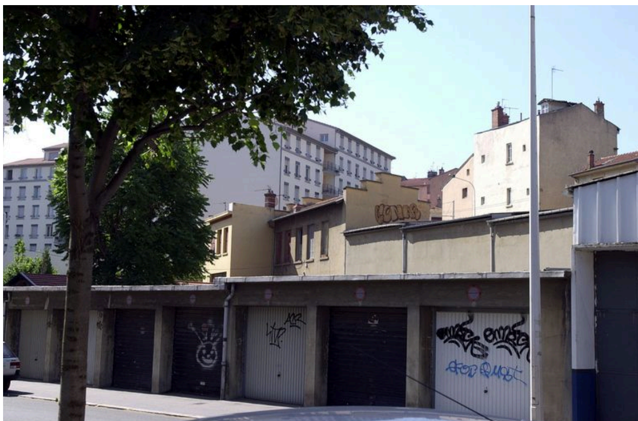
Vue générale sur la rue Artaud
