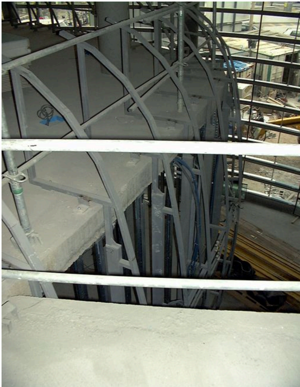
L'enveloppe de l'auditorium en cours de construction, 23 mars 2000
