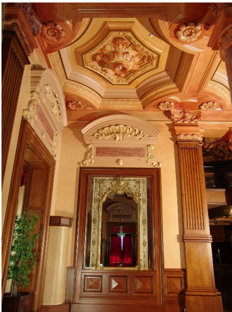
Salle du pavillon nord
