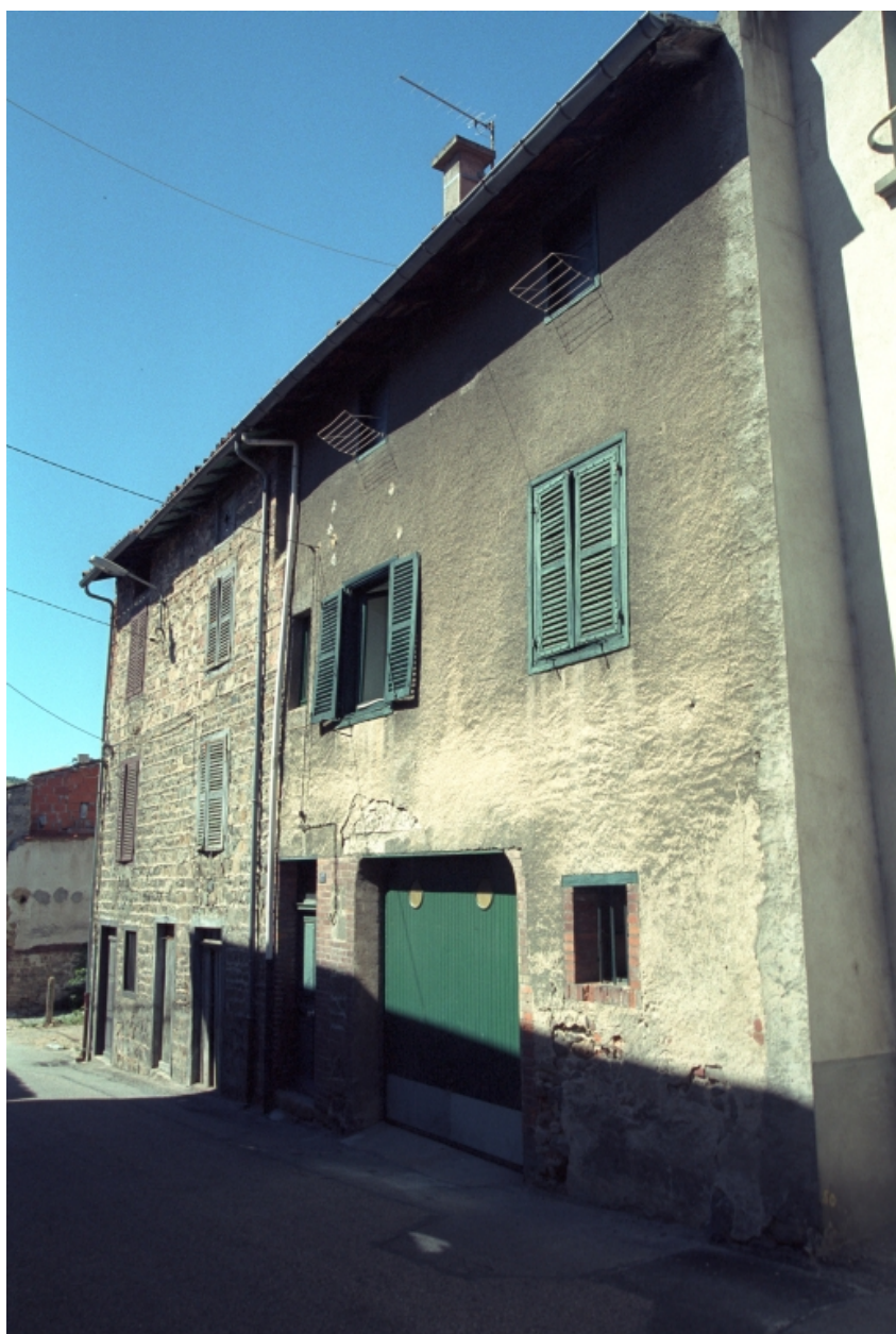
Boën, îlot 12, Ph. Raymond (rue) 17, 19, 21. Vue générale des façades sur rue.
