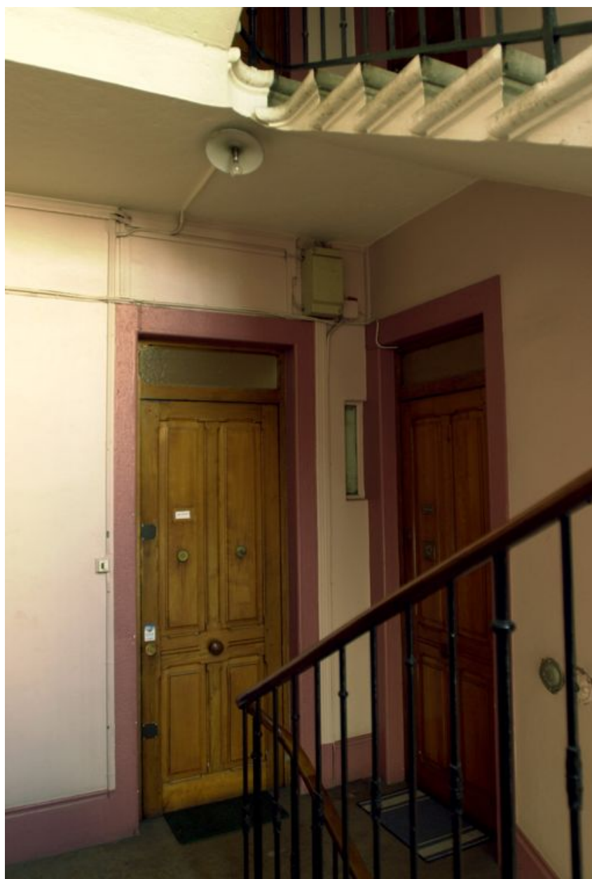
Vue des portes palières
