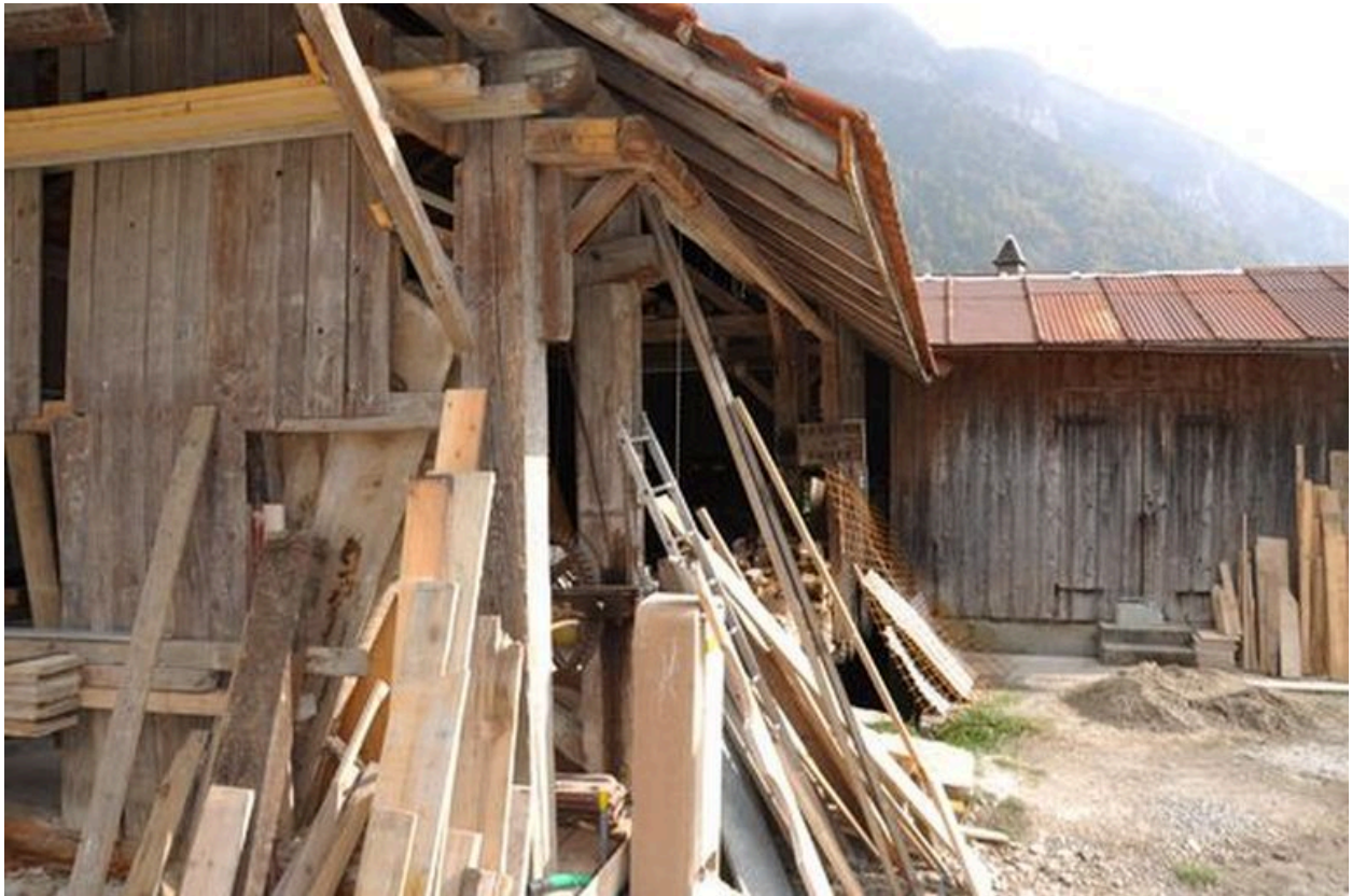
Chantier de la scierie
