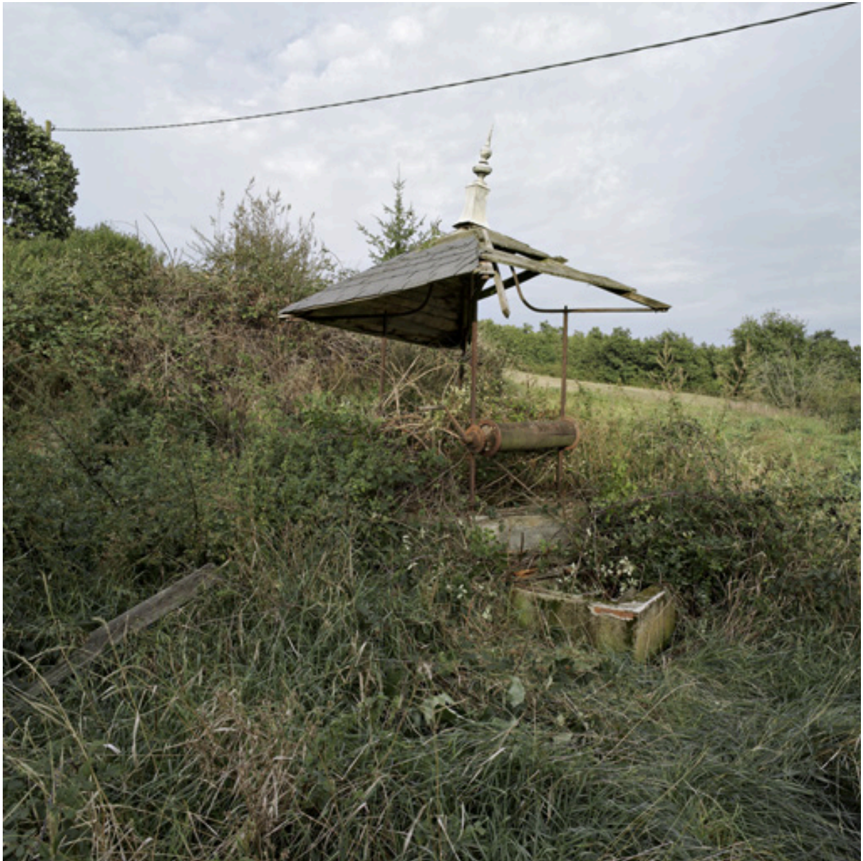
Vue du puits.
